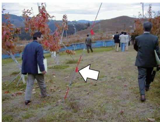
赤いリボンで目印を付けた電柱支線
