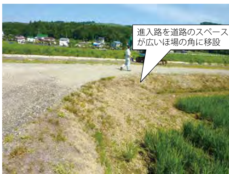
図4-3-2 ほ場進入路の改善事例
