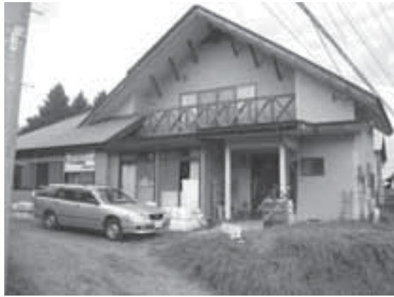
写真 151 東北地方山間地の事例 (NPO 法人事務所兼 B.D.F. 製造施設)
