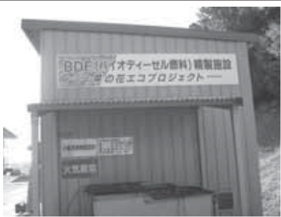
写真 149 関西地域島内プロジェクトの事例 「B.D.F.精製施設」
