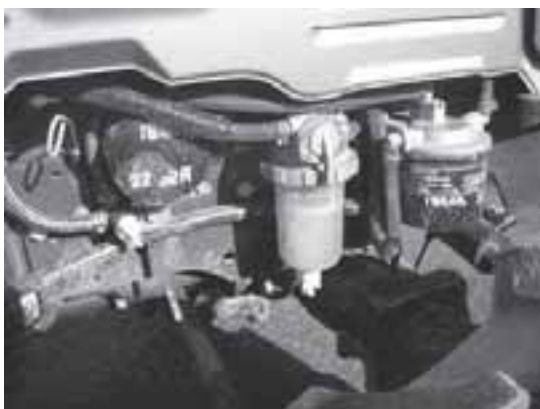
写真144 定期点検整備(平成22年2月)
