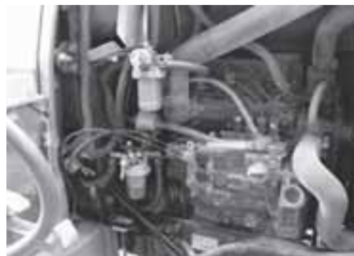
写真 147 2連燃料こし器式改造例（上側のこし器を新しく取り付け）
