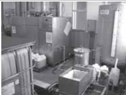
写真 94 左手前：廃食用油タンク、中央手前：濾過器、中央奥：攪拌機、奥右側：原料タンク、最奥左側：B.D.F.製造装置
