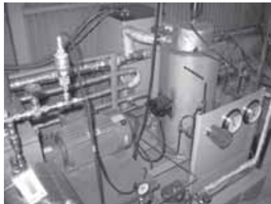
写真 136 STING 法 B.D.F.製造装置 (同左)
