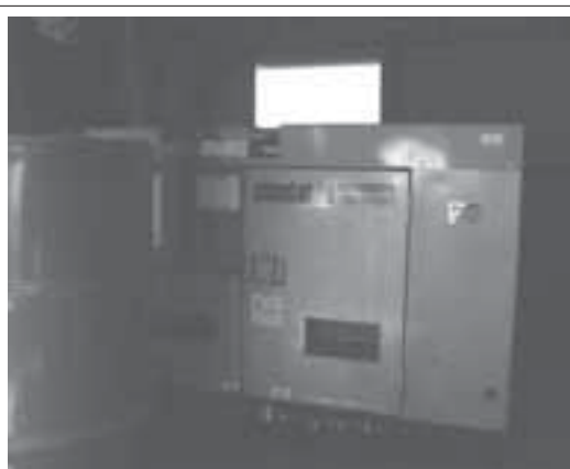
写真78 B.D.F.利用発電機（ディーゼル、15kW）
