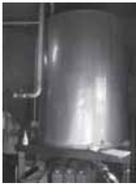
写真 88 2次貯留タンク（バキュームカーへ）
